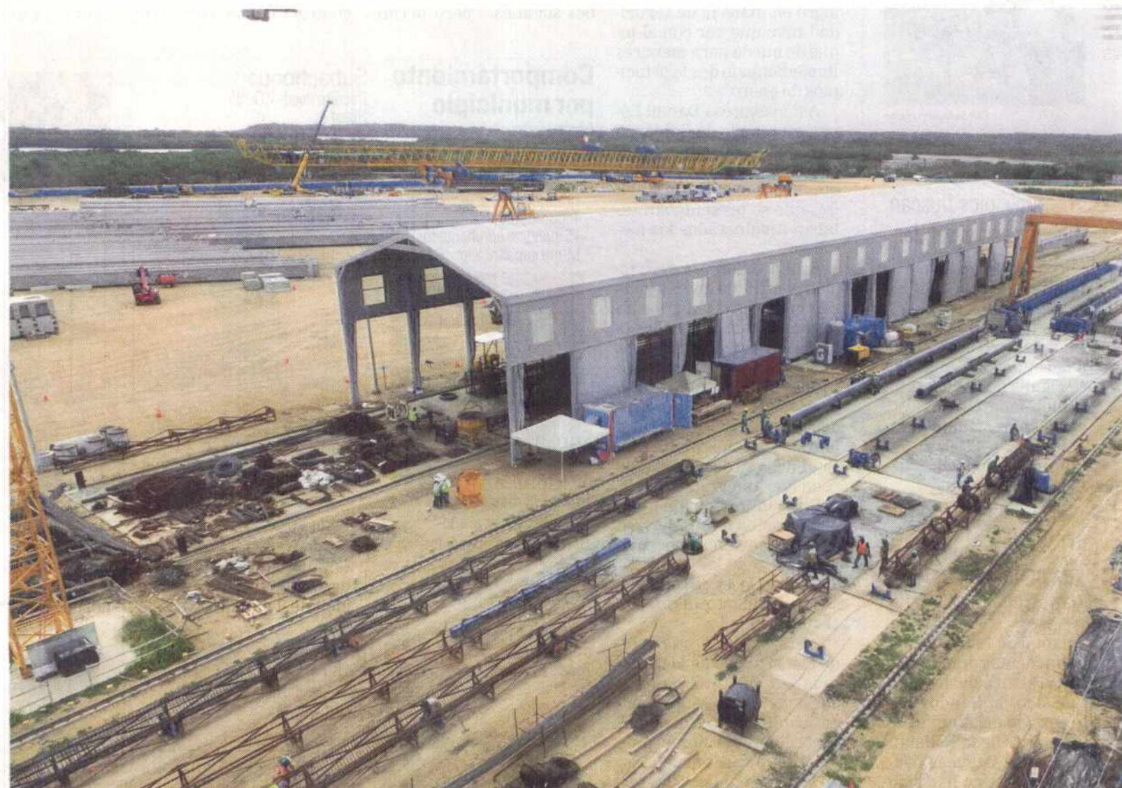
Zona donde se prefabrican las piezas del largo viaducto que se levantará sobre la ciénaga de la Virgen y que es parte de la vía 4G de Cartagena a Barranquilla y la Cir-
