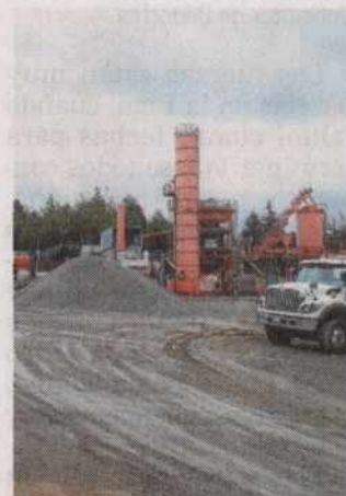
La planta de concreto asfáltico procesa 70 toneladas-hora.
